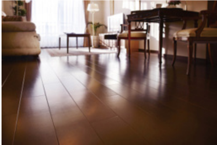
転倒時の衝撃吸収に配慮した床材と床暖房
